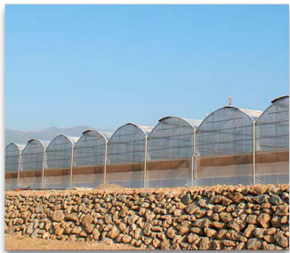
Vícar - ALMERÍA (Spain) Invernadero Multicapilla Multichappel Greenhouses 8 m. - 5 m. bajo canal 8 m. - 45 m. on canal
