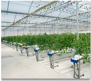
ALMERÍA (Spain) Invernadero Multicapilla Multichappel Greenhouses 8 m. - 4,5 m. bajo canal 8 m. - 4,5 m. on canal
